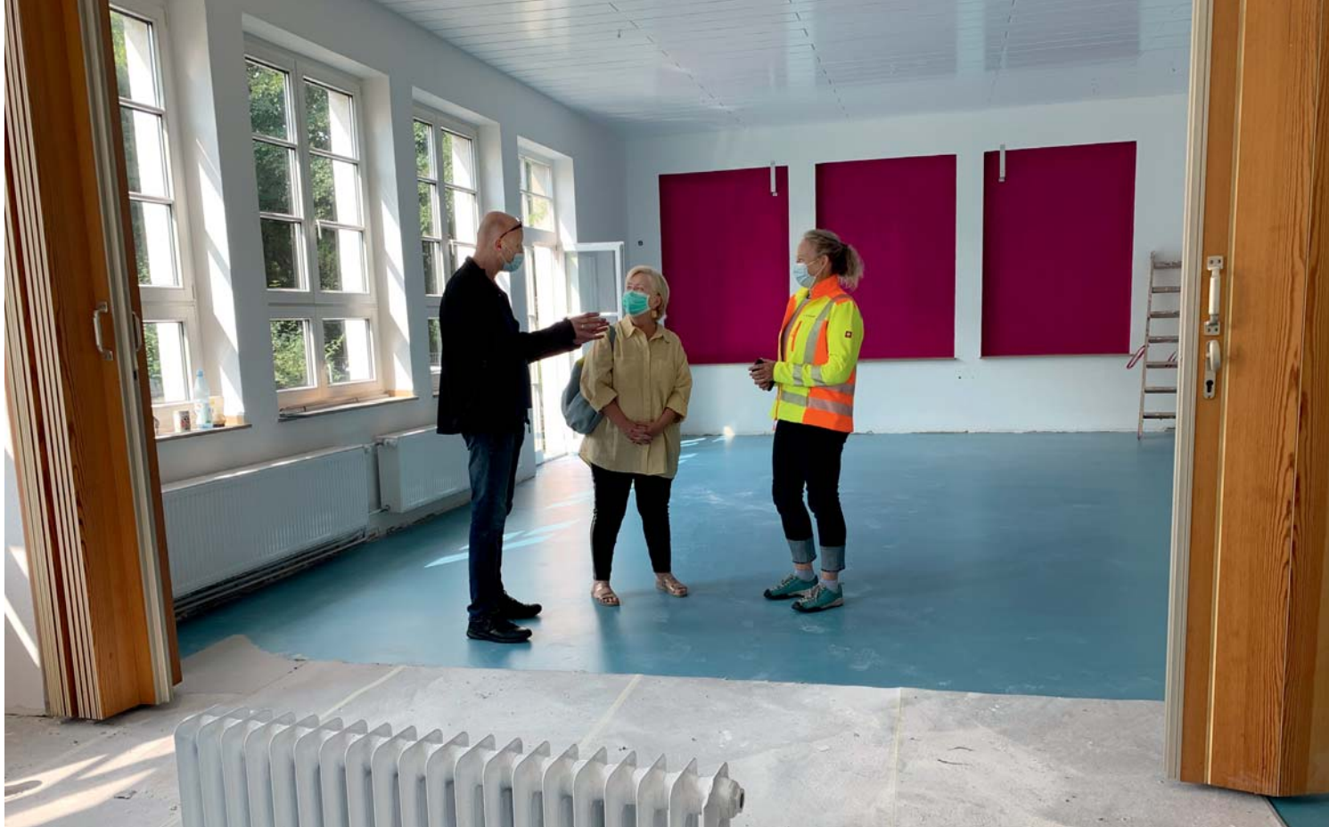
Seniorenkoordinator Jörg Saborni schaute sich mit Rita Mitic (Treff-Koordinatorin) und Bauleiterin Heike Schroeder (v.l.) die Baufortschritte im grundrenovierten Seniorentreff Süd am Karl-Mücher-Weg an. Foto: J. Dangelmeyer
