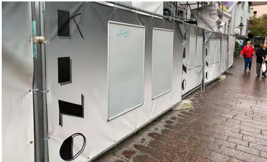
Während der Fassadensanierung war das Ratinger Kino außen durch Sichtwände verhüllt, momentan wird noch innen umgebaut. Foto: J. Dangelmeyer
